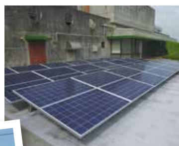
県庁別館太陽光発電設備設置工事
