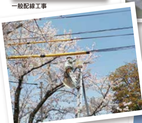
外灯改修工事
