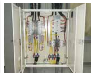
動力分電盤工事
