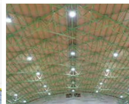
下郡小学校体育館照明LED化工事
