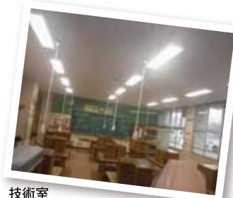
技術室 リーラーコンセント取付
