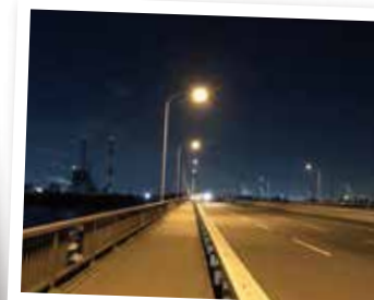
道路照明LED化工事
