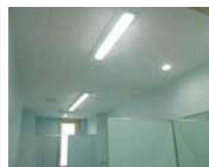
一般配線工事
