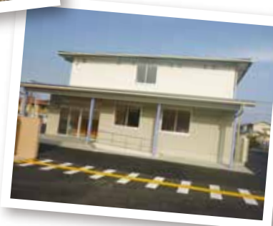
大分市立情緒障害児短期治療施設 (現・愛育学園はばたき) 併設校新築電気設備工事
