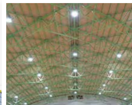
下郡小学校体育館照明LED化工事
