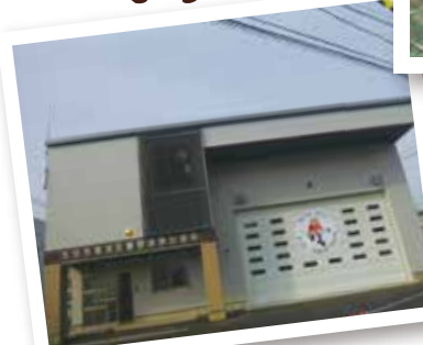
大分南消防署野津原出張所 電気設備工事
