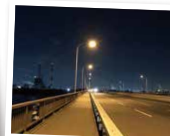
道路照明LED化工事
