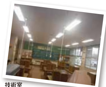
技術室 リレーコンセント取付
