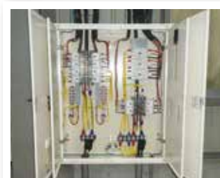
動力分電盤工事
